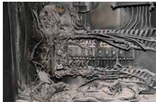
▲ 배전반 화재 사진 _ TS-60은 이러한 화재를 초기에 감지하여 피해를 최소화 하는 제품이다.
